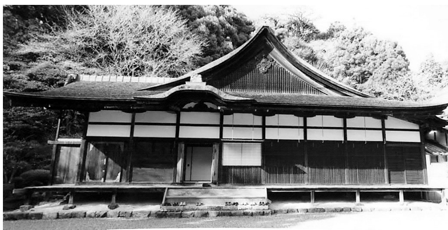
国宝 園城寺光浄院客殿 （左が中門、車寄せに軒唐破風屋根を付け部戸と板唐戸を建込む）
